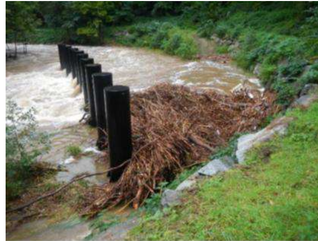
Exemple de piège à embâcles avec IPN en diagonal
