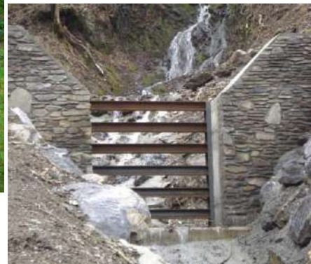
Exemple de piège à embâcles avec IPN en diagonal
