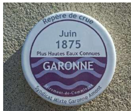
Figure 138 : Photographie d'un des repères de crues normalisés, posé à Miramont-de-Comminges
