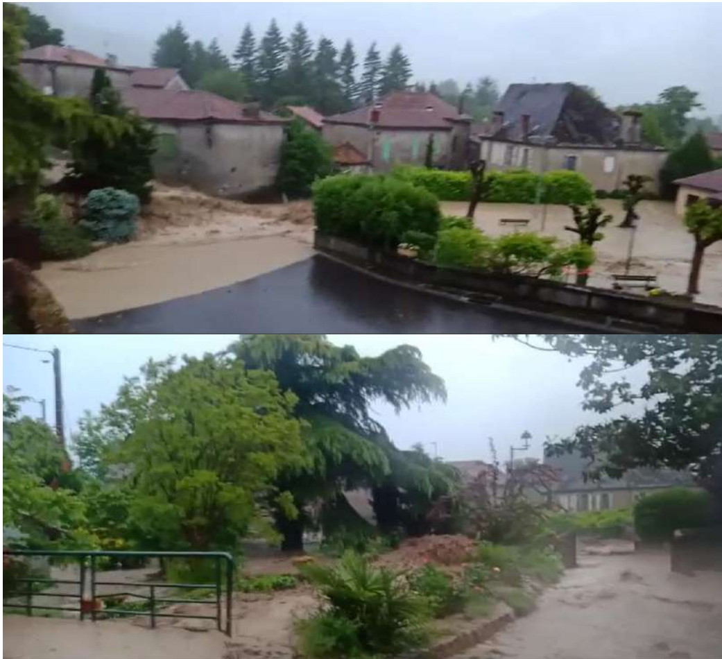
Figure 8 : Surverse du mur de berge engendrant l'inondation de la rue de la Montjoie sur la commune d'Ore (clichés M. HEIB)
