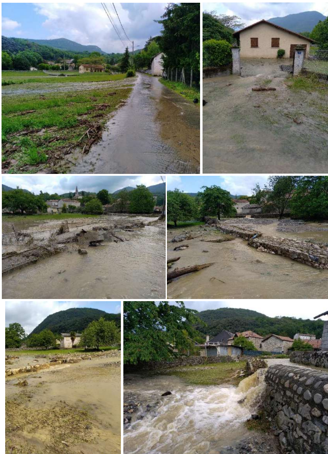
Figure 9: Planche photographiques des dégâts observés en rive droite du ruisseau du Sarté suite à la rupture du muret sur la commune d'Ore
