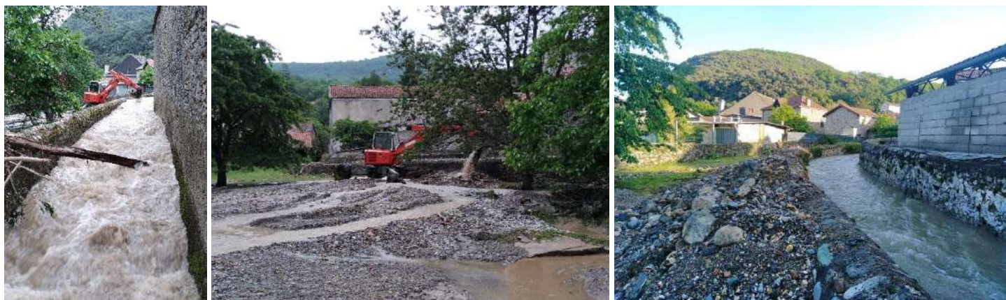
Figure 11: Photographies pendant les travaux d'urgence impérieuse et à droite après les travaux (fermeture temporaire de la brèche avec les matériaux extraits du lit du ruisseau du Sarté)
