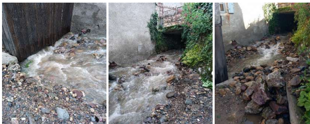
Figure 21: Photographies avant/après (à droite) du dés-engravement du lit du torrent dans le village de Frontignan-de-Comminges
