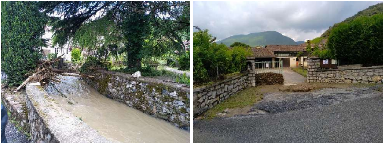
Figure 7: Coude du Ruisseau du Sarté et salle des fêtes impactée sur la commune d'Ore
