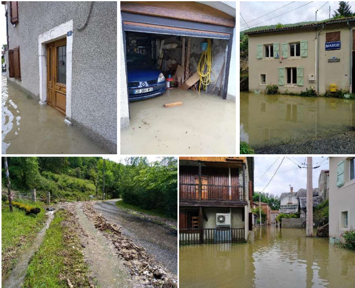
Figure 15: Planche photographiques des niveaux d'eau et des dégâts observés sur la commune de Galié
