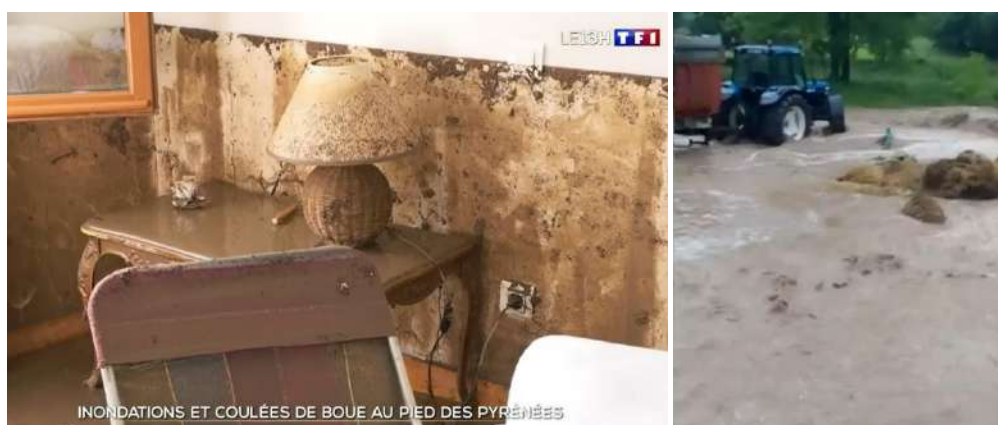
Figure 18: Photographies des dégâts causés par les fortes précipitations du 24 mai 2023 sur la commune de Génos (photos extraites du JT diffusé sur TF1, disponible sur : https://www.tf1info.fr/meteo/video-genos-meteo-orages-inondations-et-coulees-de-boue-en-haute-garonne-2258243.html )
