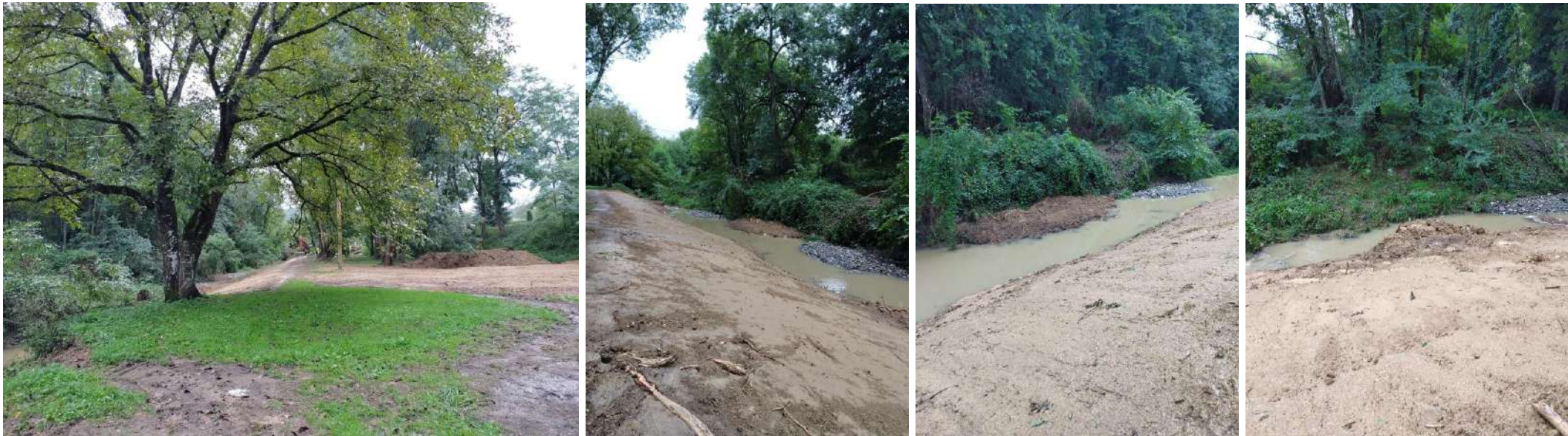
Travaux en cours depuis le 1 er septembre 2025
