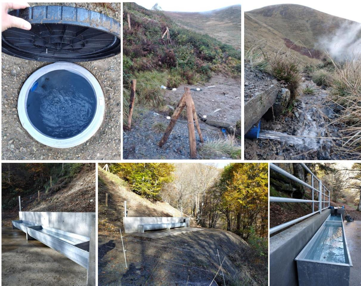
*Figure 32: Photographies après travaux de réhabilitation du captage d'une source et des abreuvoirs sur l'estive du Céciré*
