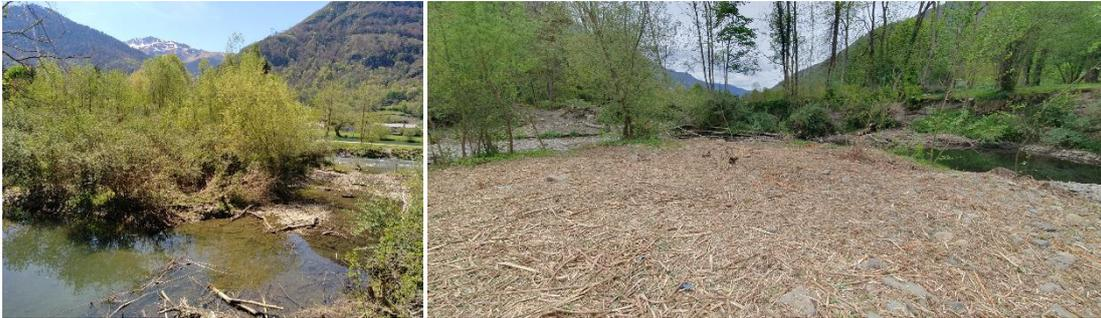
*Figure 20: Photographies avant/après travaux de dévégétalisation de l'atterrissement situé à proximité du lac de Bادهچ sur la commune de Bagnères-de-Luchon*
