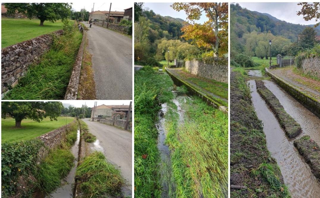
*Figure 26: Photographies avant/après des travaux d'entretien de végétation effectués sur les cours d'eau des communes de Saléchan et Saint-Bertrand-de-Comminges*
