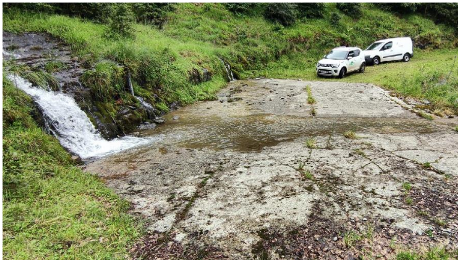
Figure 18: Photographie du passage à gué bétonné des sources du Rossignol
