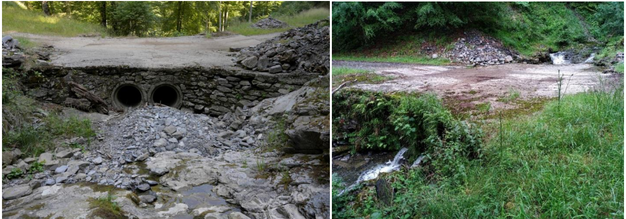
Figure 17: Photographie du ruisseau du Rossignol et de la double buse (à droite vue depuis l'amont, à gauche vue depuis l'aval)
