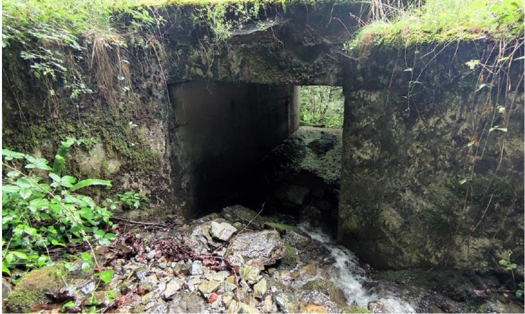
Figure 16: Photographie de l'ouvrage au niveau du ruisseau de Loze
