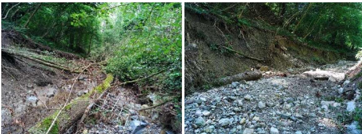
Figure 20 : Photographies avant/après travaux de retrait d'embâcles et de déchets sur le ruisseau du Sarté sur la commune de Lourde suite à la crue du 24 mai 2023
