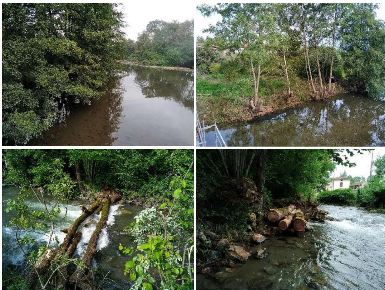
*Figure 9 : Planche photographiques avant - après travaux de coupe sélective d'arbres sur la commune de Pointis-Inard et de gestion d'embâcles sur la commune d'Aspet*
