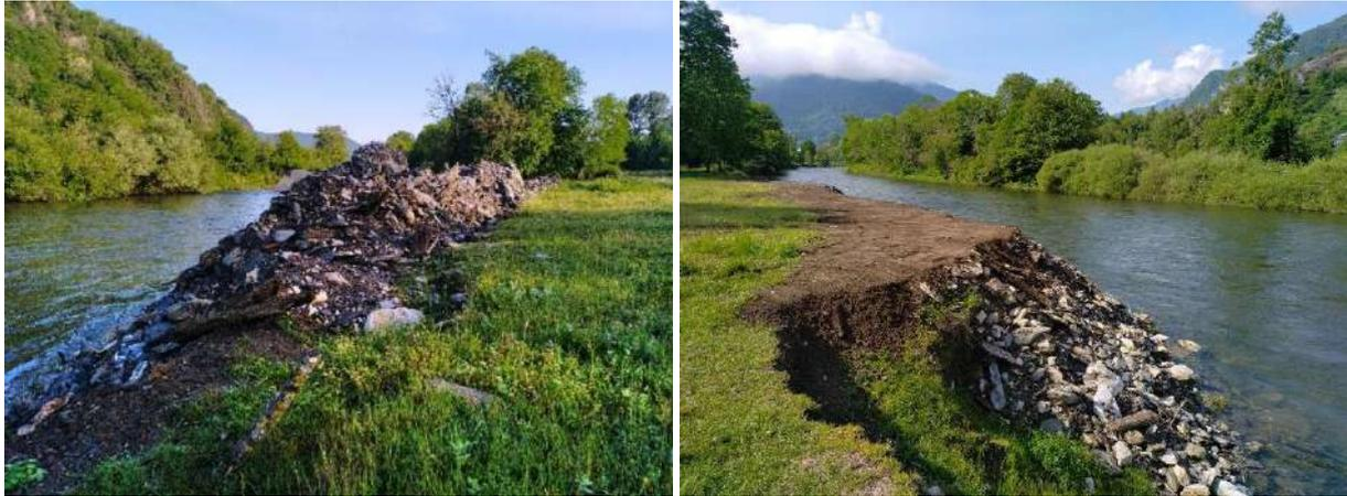
Figure 27 : Photographies avant/après travaux de régalinge des matériaux réinjectés à hauteur du terrain naturel en rive droite de la Garonne sur la commune de Chaum
