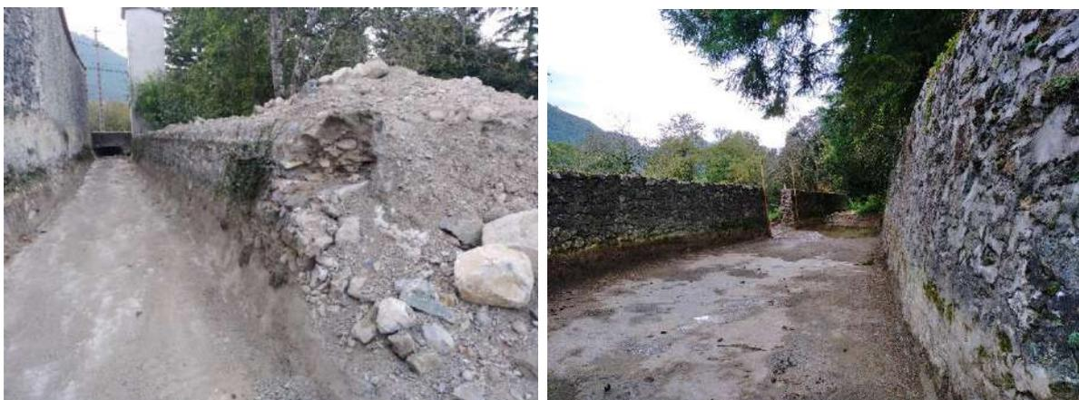
*Figure 32 : Photographies de la chenalisation dont la capacité maximale d'écoulement a été rétablie sur le ruisseau du Sarté – Commune d'Ore*
