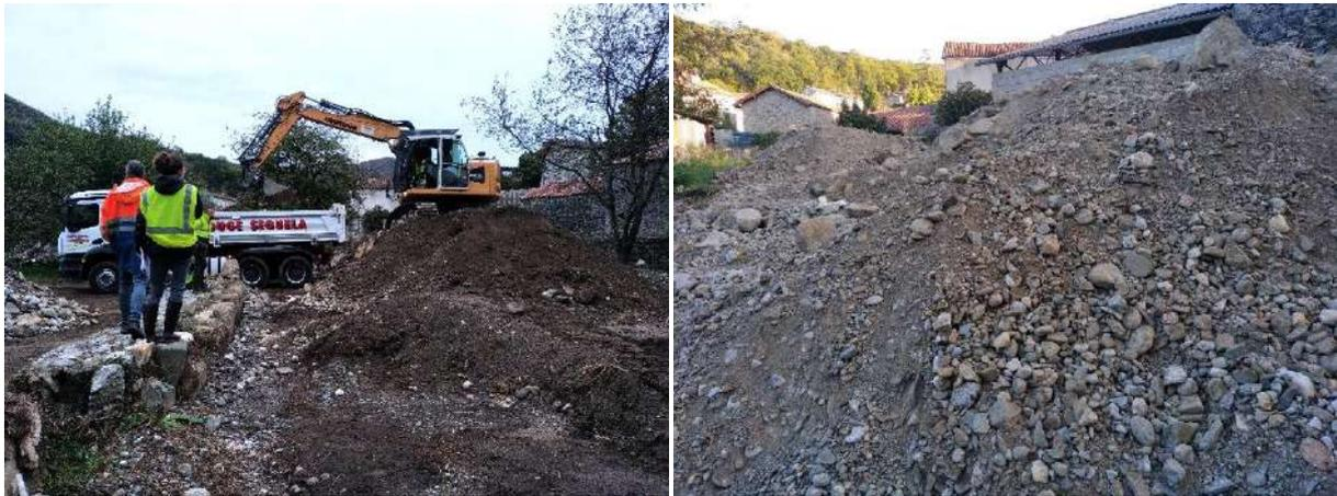
*Figure 30 : Photographies pendant les travaux de retrait de sédiment de la chenalisation, stockage temporaire sur une parcelle privée et évacuation par camion sur le site de réinjection*
