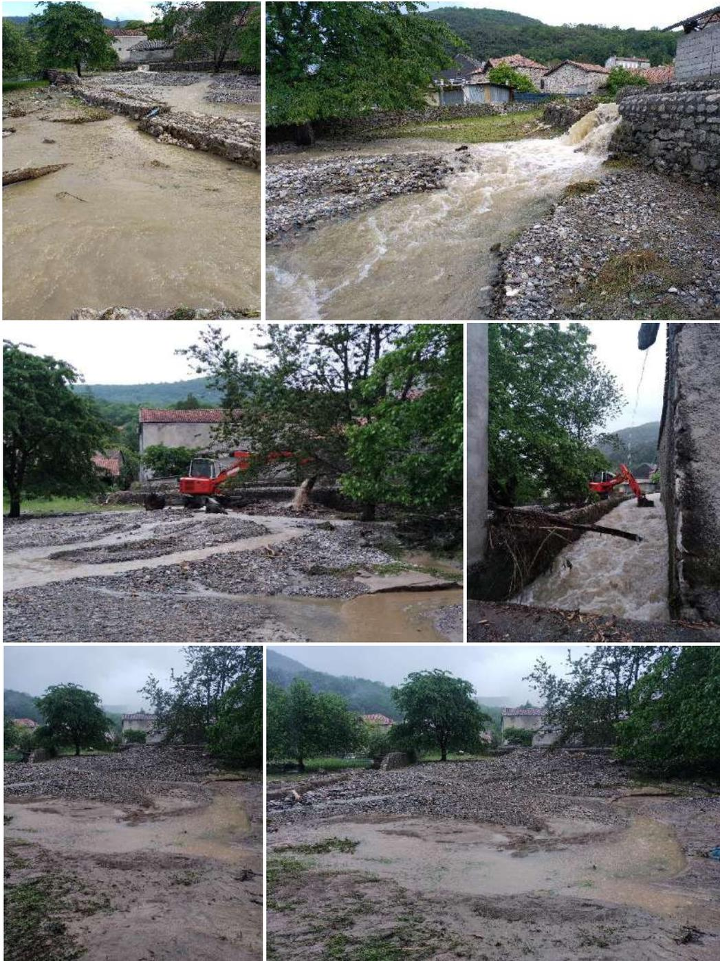
*Figure 29 : Photographies de la rupture du mur de berge et photographies pendant et après les travaux d'urgence impérieuse réalisés le 25 mai 2023 sur le ruisseau du Sarté - Commune d'Ore*
