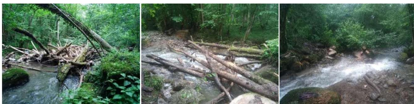
Figure 22 : Photographies avant/pendant/après travaux de retrait d'embâcles sur l'Ourse de Sost sur la commune d'Esbareich
