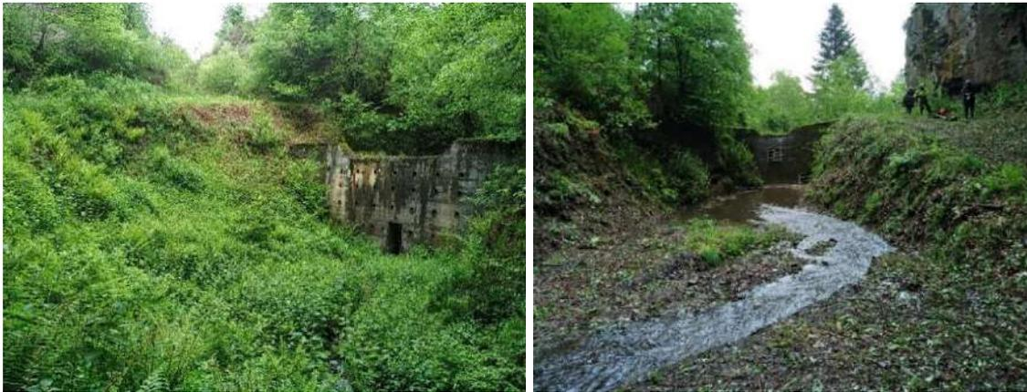
*Figure 24 : Photographies avant/après travaux d'entretien de la végétation sur la plage de dépôt située sur le ruisseau de Sainte Christine sur la commune de Montauban-de-Luchon*
