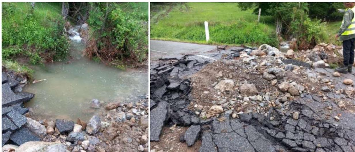
Figure 19: Photographies du colmatage du passage busé sous la RD9a par les matériaux transportés par l'Arrieu Sec et dégâts causés sur la chaussée (crédit photos : RTM)
