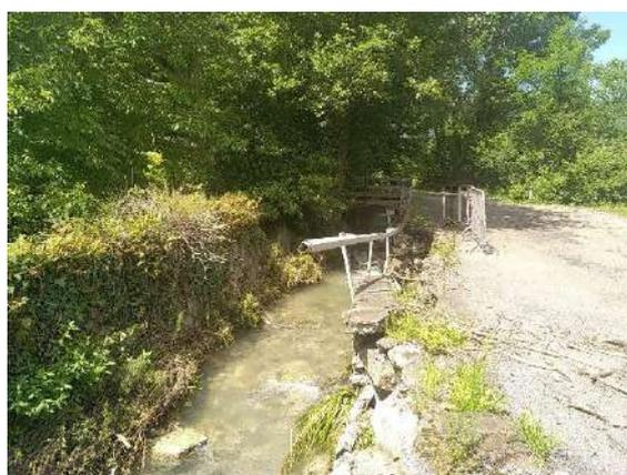
Figure 20: Photographie des dégâts causés sur le mur de soutènement de la voirie suite aux fortes précipitations du 24 mai 2023 sur la commune de Sauveterre-de-Comminges (Boucou)
