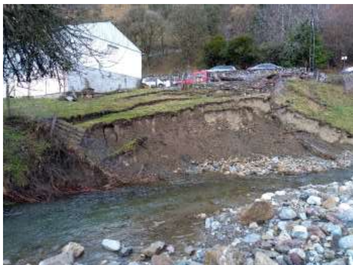
Figure 31 : érosion de berge associées à un mouvements de terrain en rive gauche de l'Ourse de Sost sur la commune de Sost
