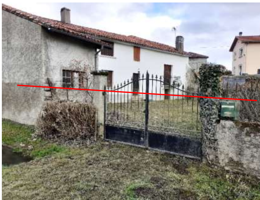
Figure 22 : Laisses de crue sur une habitation de Ponlat-Taillebourg ( trait rouge : niveau d'eau maximal atteint lors de la crue de janvier 2002 )
