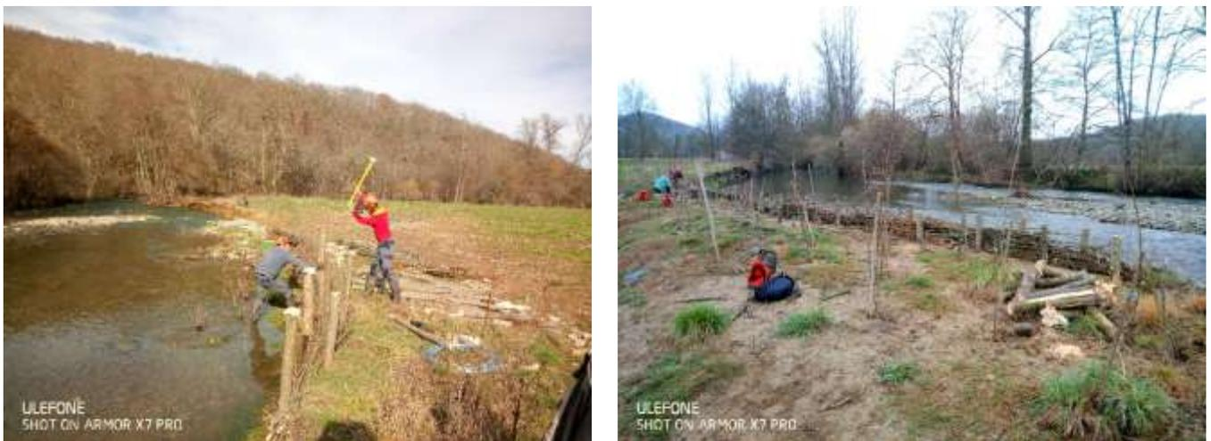
Figure 14 : Photographies de la fascine et de la plantation sur le Job entre Encausse-Les-Thermes et Lespiteau.
