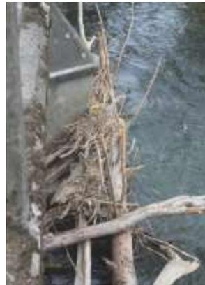
*Photographie d'un embâcle formé sur la pile d'un pont sur la Pique à Cierp-Gaud.*
