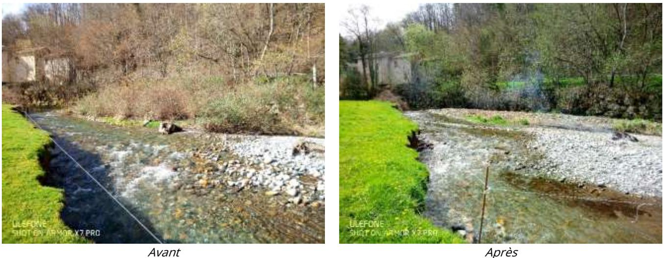
Figure 12 : Photographies des travaux de dévégétalisation d'un atterrissement sur le Ger au Tucaou.
