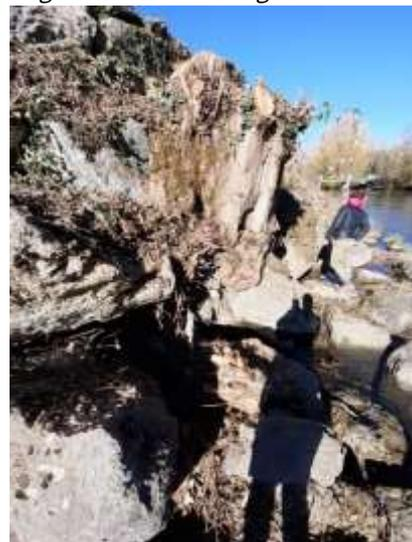
*Photographie des différentes pathologies constatées sur les enrochements de la digue de Loures-Barousse (photographie de gauche, en orange, blocs d'enrochements manquants dans l'ouvrage / photographie de droite souche présente dans l'enrochement)*
