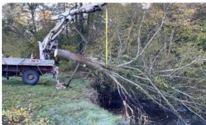
*Photographies des travaux externalisés (enlèvement d'embâcle à risque à Pointis-Inard)*
