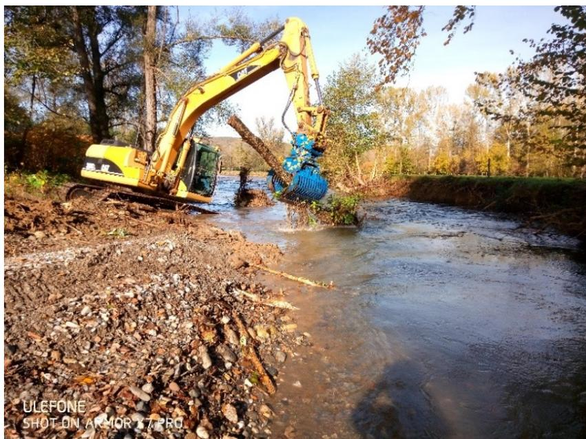
Figure 6 : travaux d'enlèvement d'embâcle sous-traité à l'entreprise Sopytrap.
