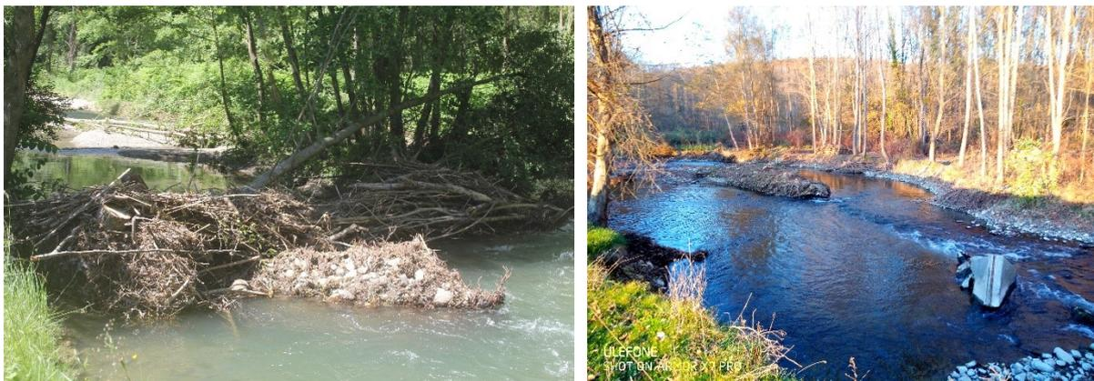
Figure 11 : photographies avant/ après de travaux de dévégétalisation d'un atterrissement sur le Ger en amont de Lespiteau.
