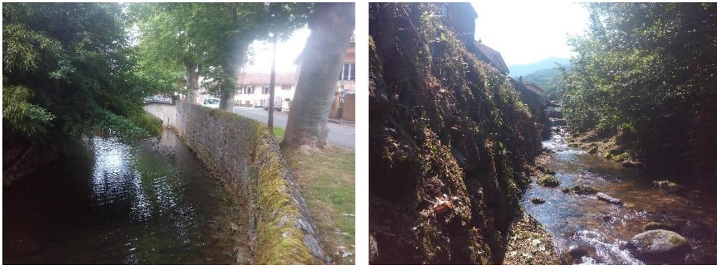
*Figure 7 : photographies de murs de berges ayant fait l'objet d'un entretien par dévégétalisation à Encausse-Les-Thermes et à Milhas.*
